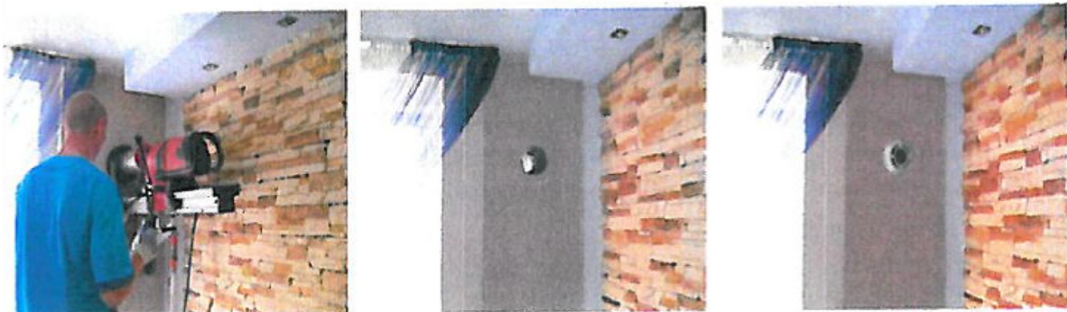
Kuva 4. PRANA-150, PRANA-200G ja PRANA-200G asennus.
